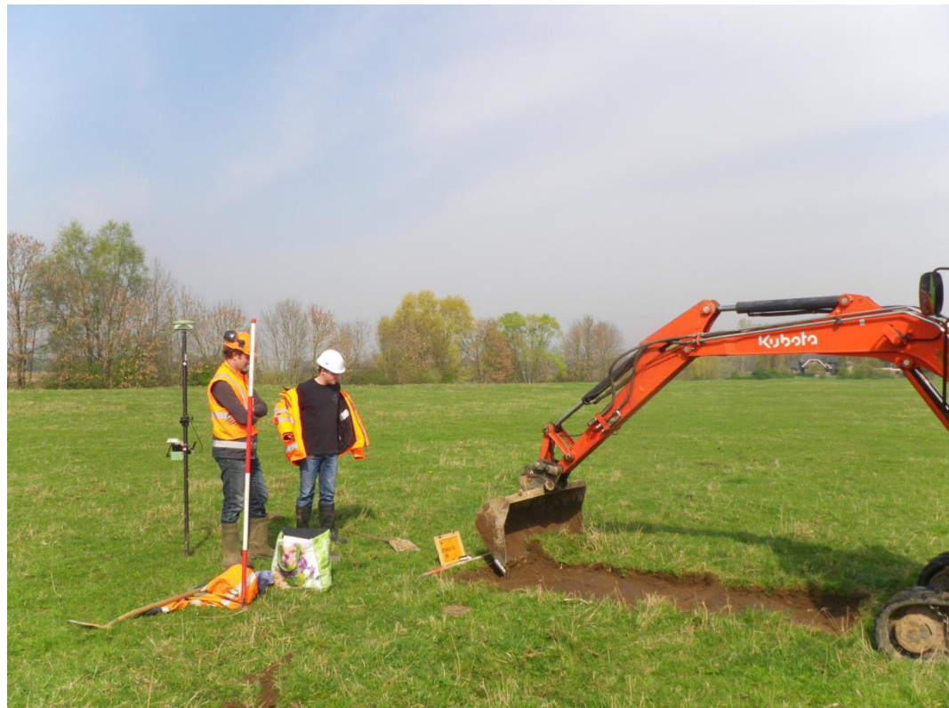
Afb. 6 Het verwijderen van de grasmat bij het aanleggen van een proefput.
